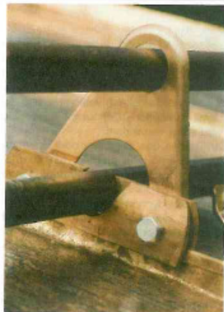
Bild 1.: Diese Detailaufnahme zeigt die Befestigung der Rohre mit Klemmlaschen an den Längs-Stehfalzen des Metalldaches.
